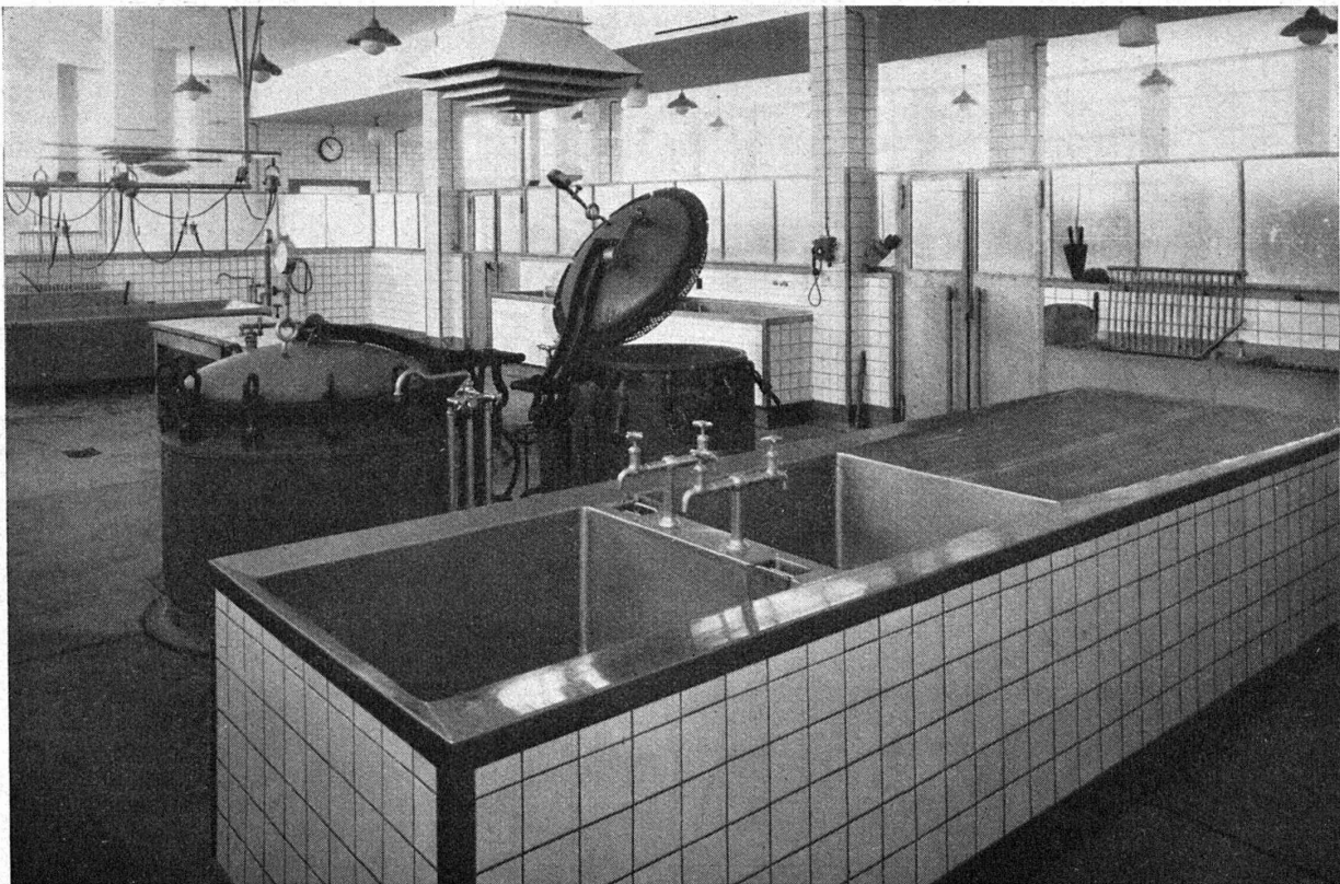
Abattoirs de Genève. — Vue d'une des halles. Revêtement de verre-céramique KerVit.
