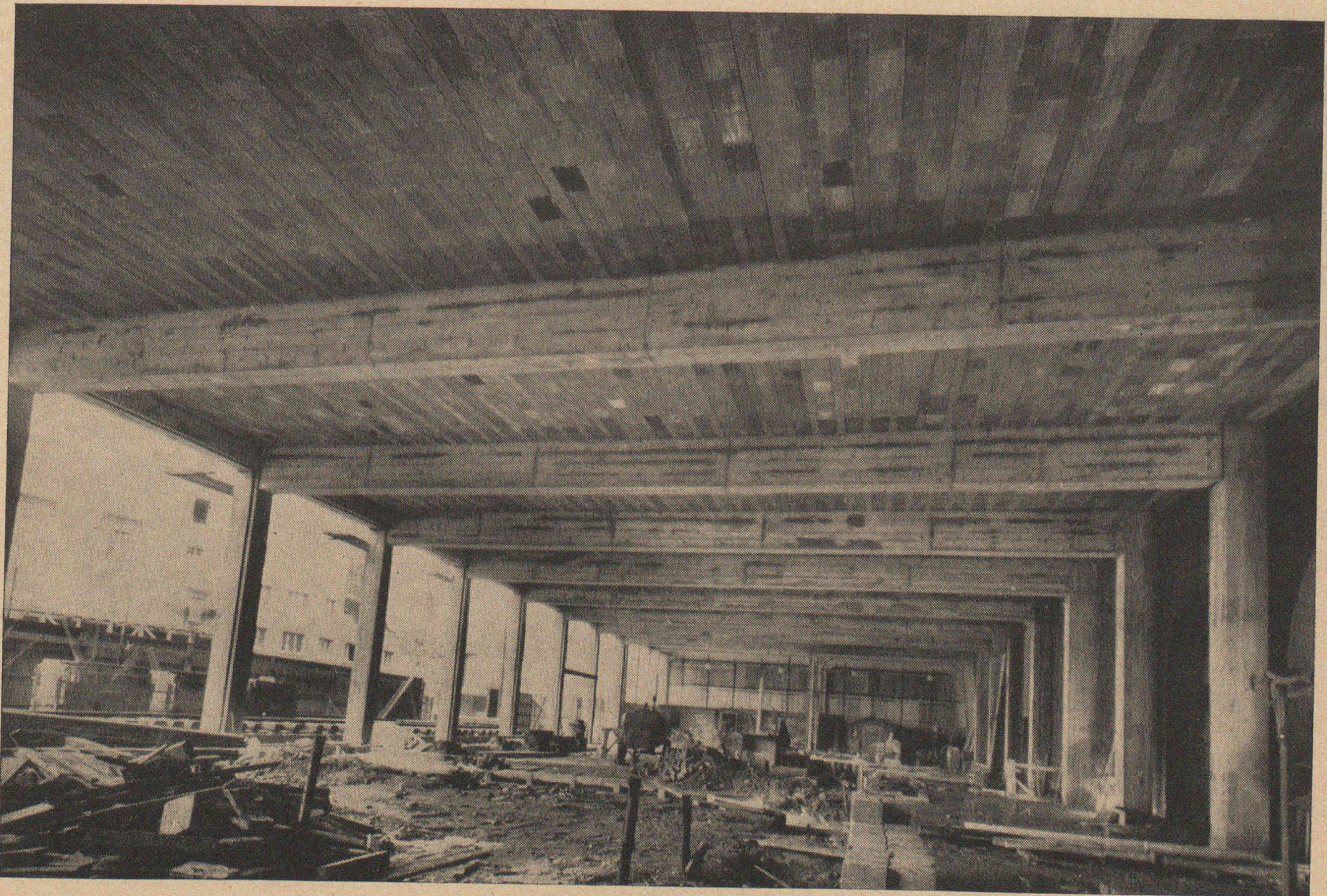
Agrandissement du Palais des Expositions, Genève : sommiers en béton précontraint et dalles préfabriquées précontraintes STAHLTON Arch. : E. Martin. — Ing. : Froidevaux et Weber. — Entr. : Ed. Cuénod S. A.
