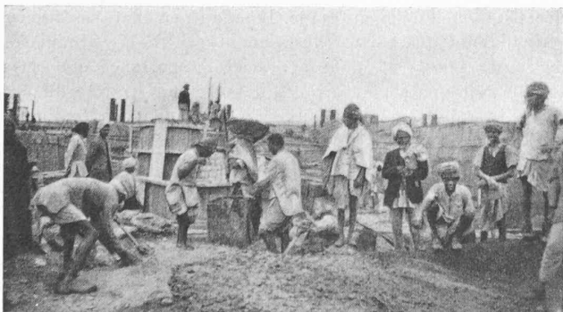
Fig. 3. — Barrage de Nangal. Fabrication du béton.
