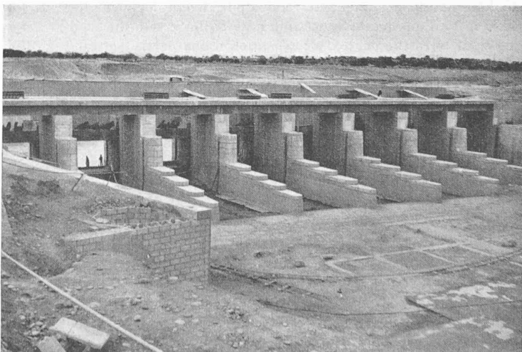
Fig. 7. — Barrage de Nangal. Ouvrage d'entrée du canal de dérivation.
