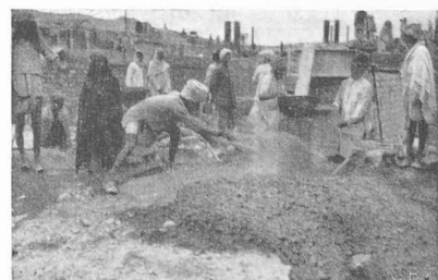
Fig. 13. — Barrage de Nangal. Fabrication du béton; le dosage en ciment.
