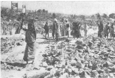
Fig. 16. — Barrage de Hirakud. Transports des matériaux d'excavation.
