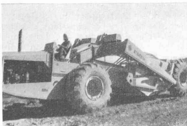
Fig. 17. — Barrage de Hirakud. Scraper Le Tourneau.
