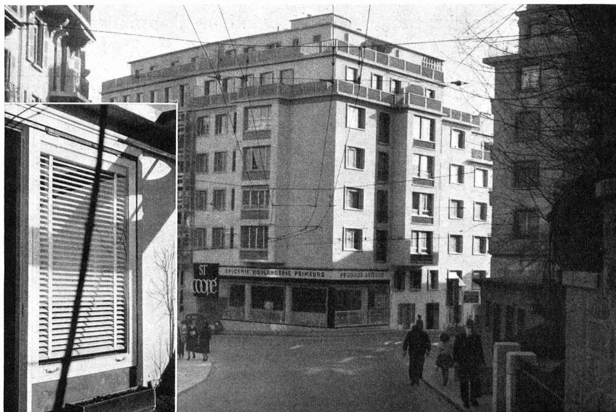
Façade ouest de l'immeuble de la S. A. Valentin-Vinet B à Lausanne.
