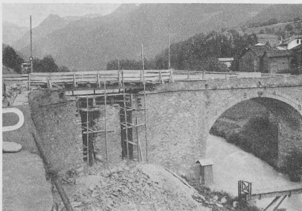
Fig. 6. — Percement de la culée du pont existant.
