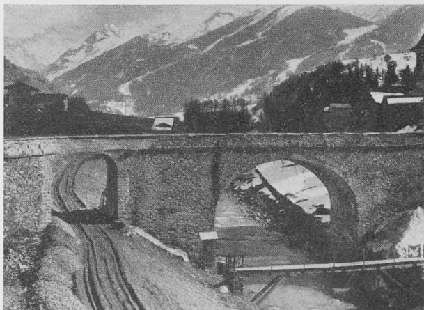
Fig. 7. — Le tunnel terminé.
