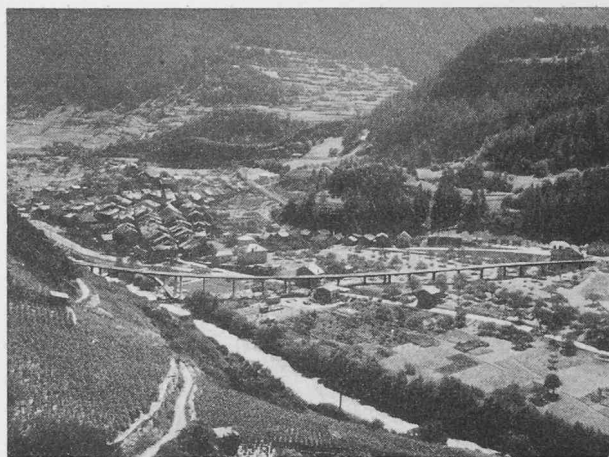
Fig. 5. — Le bourg de Sembracher. En aval, le nouveau viaduc.
