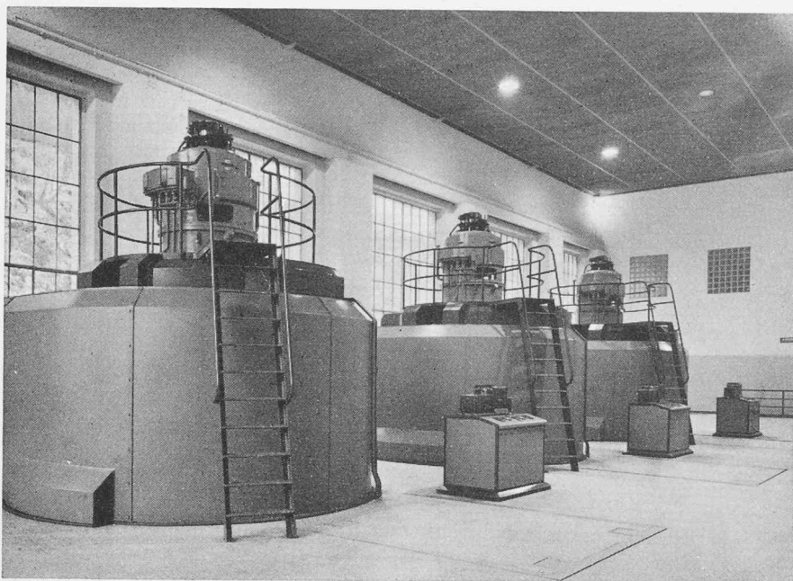
Fig. 6. — Salle des machines de l'usine de Montcherand dès 1950. 3 groupes de 5000 CV.
