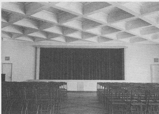
Fig. 5. — Vue du plafond.
