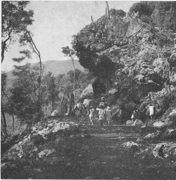
Fig. 5. — Terrassement voie usine-carrière.
