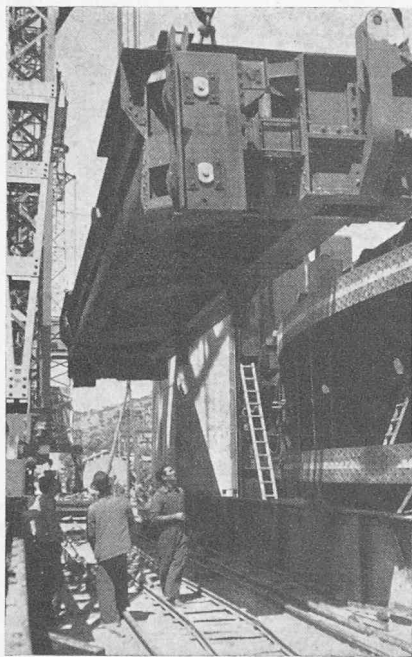
Fig. 8. — Une vanne du barrage en montage. A droite en bas, le panneau inférieur, déjà monté. On en distingue les deux poutres maîtresses en position horizontale. En haut, la poutre maîtresse du panneau supérieur, suspendue à deux portiques de montage (non visibles), quelques instants avant d'être placée dans sa position définitive.
