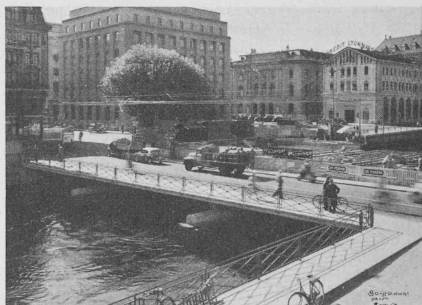
Fig. 16. — Pont B. G. La moitié amont du tablier terminée.
