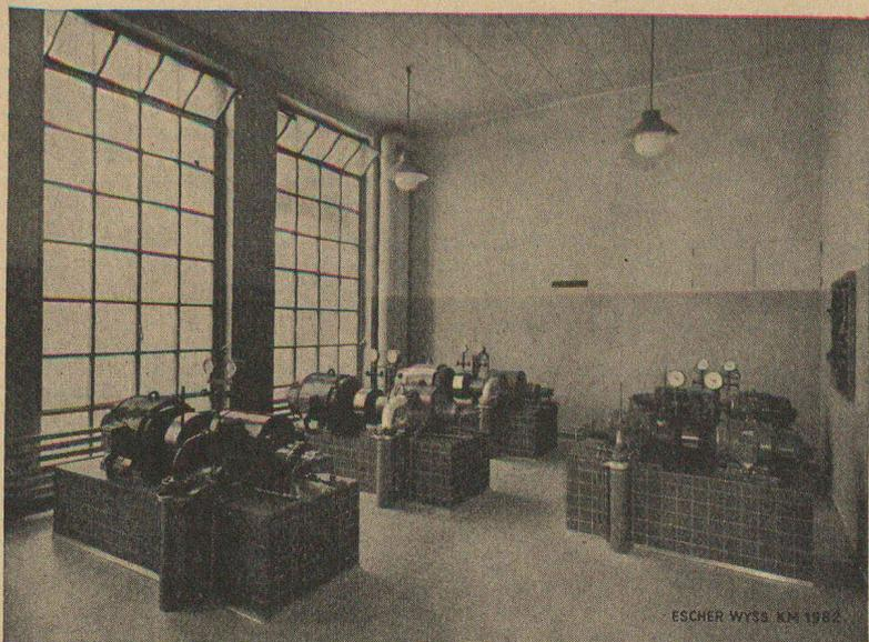
5 compresseurs «ROTASCO» pour la réfrigération
