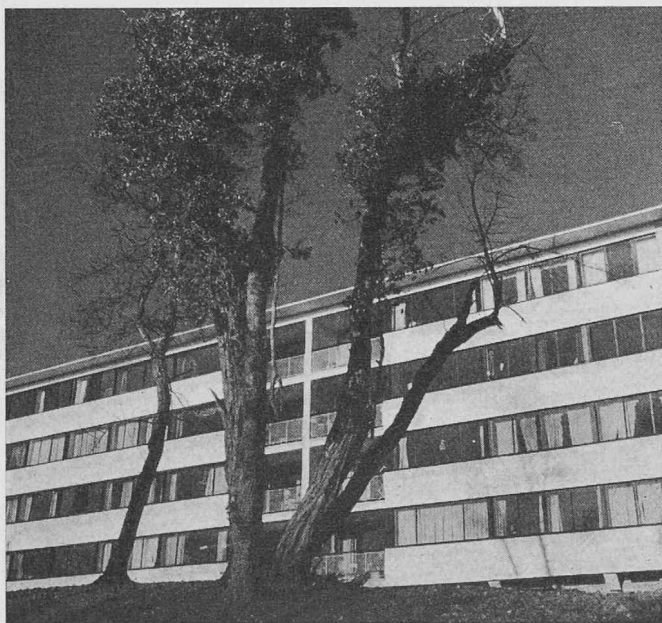
Fig. 41. — Bâtiment 2, façade sud.
