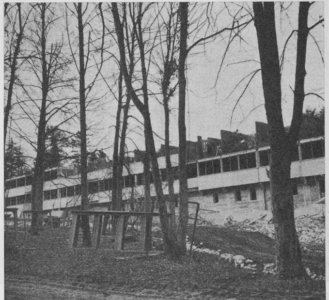
Fig. 47. — Une phase du chantier.
