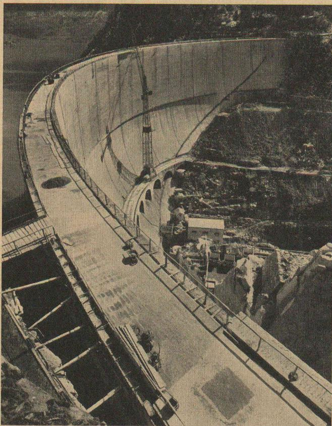
Barrage de Forte Buso, 120 000 m<sup>3</sup> de béton à un entraîneur d'air ordinaire, ensuite 140 000 m<sup>3</sup> de béton au FRIOPLAST.
