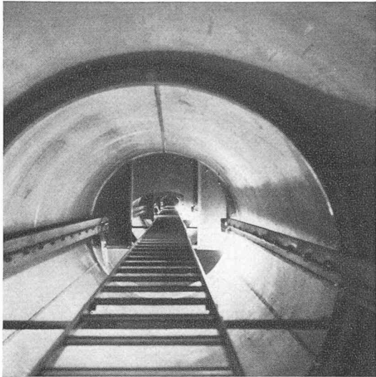
Fig. 8. — Eclairage de l'intérieur de la tour, avec plates-formes intermédiaires et montées des câbles électriques à gauche et à droite de l'échelle.
