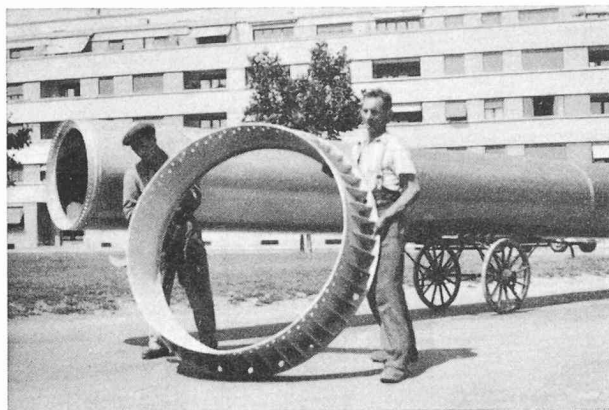
Fig. 14. — Transport d'un tronçon de 9 m de long composé de trois éléments soudés. Au premier plan, la couronne en acier.
