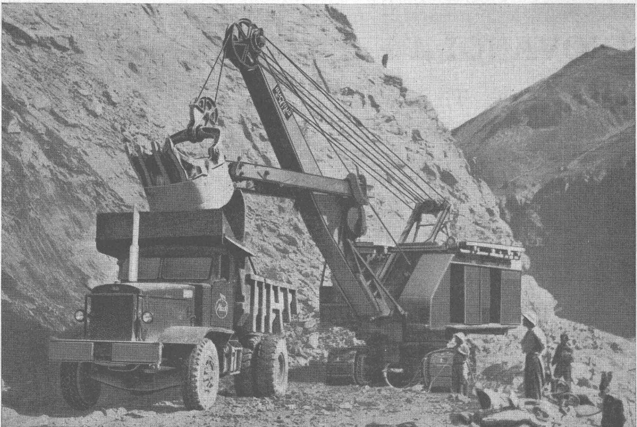
Excavateur BUCYRUS-ERIE 54 B à commande électrique Ward Leonard 1900 l avec camion-basculeur MACK LR 7,5 - 10 m 3 , 275 CV, sur le chantier de la Grande Dixence. Vente exclusive pour la Suisse : Robert Aebi & Cie S. A., Uraniatr. 31, Zurich.
