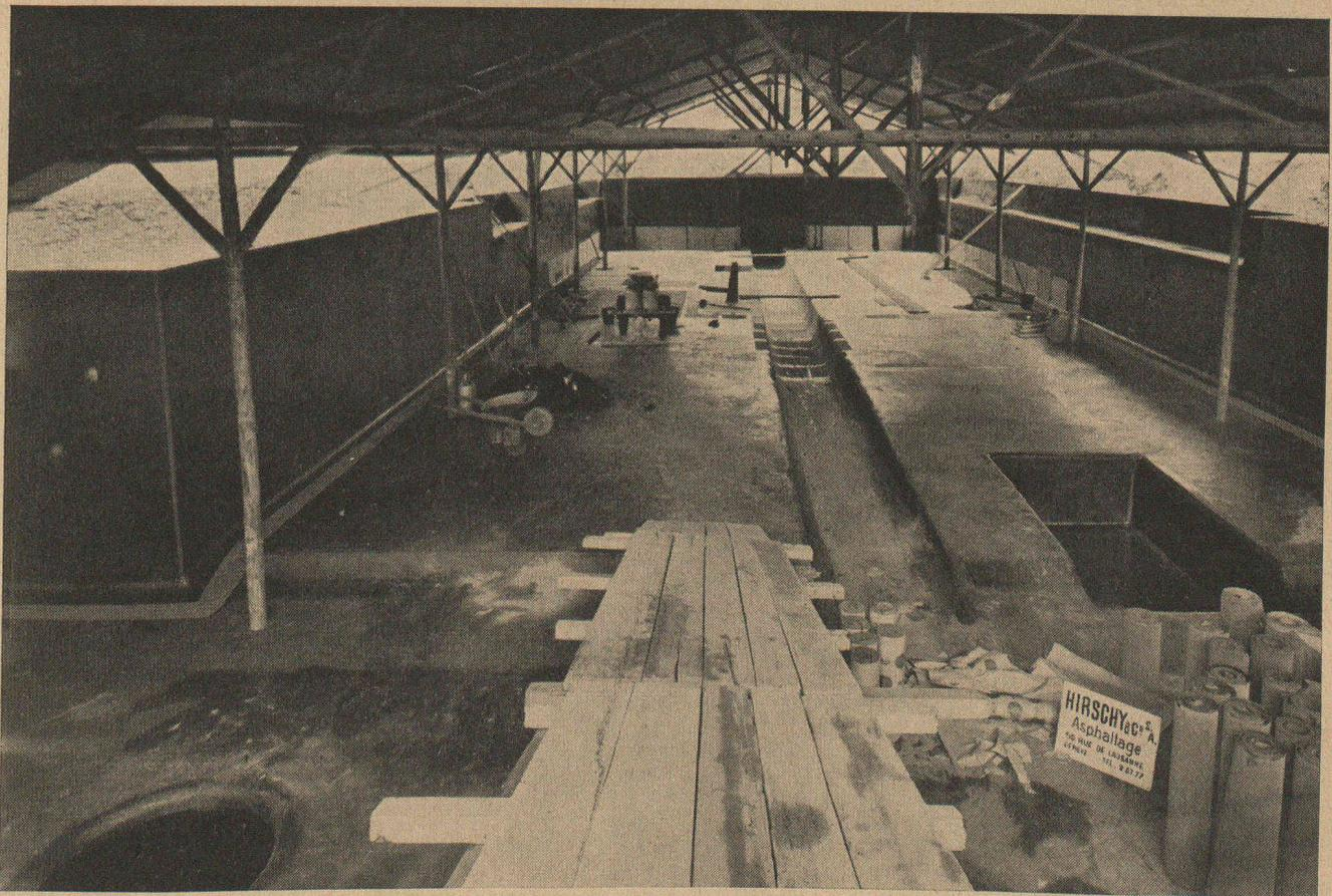
Travaux d'étanchéité effectués dans le cuvelage d'un bâtiment municipal à Genève par procédé multicouches HIRSCHY S. A.
