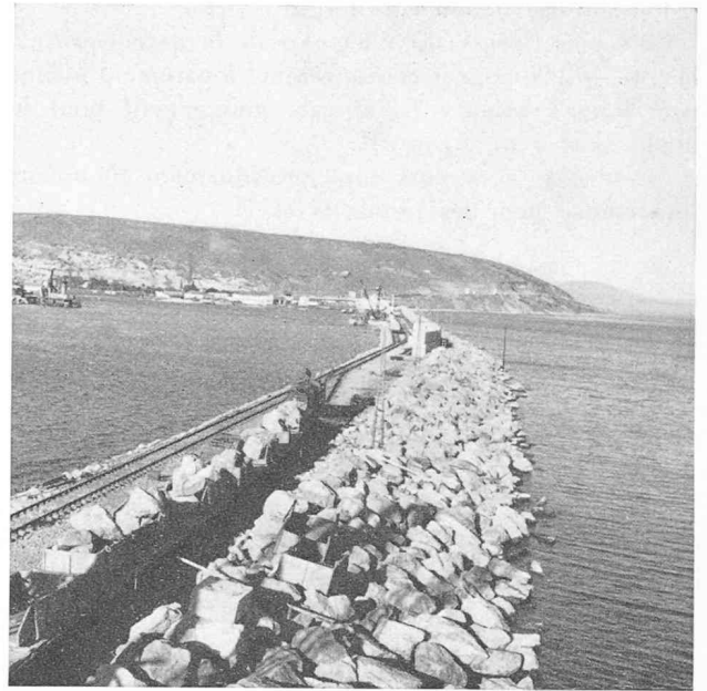
Fig. 34. — Vue prise en octobre 1955, pendant la construction de l'ouvrage à Samsun.
