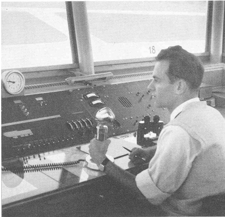
Le contrôle d'aérodrome avec le tableau de commande des divers balisages lumineux, les commandes d'alarme et, outils par excellence de tous les contrôleurs, la montre et le microphone.
