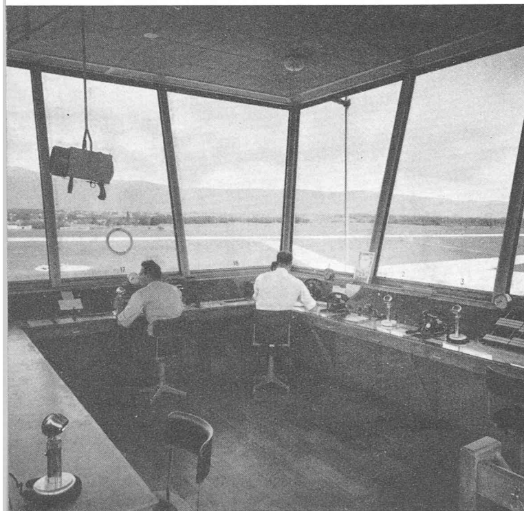
Vue intérieure de la tour de contrôle. Suspendue au plafond, la lampe à signaux qui permet de donner des ordres aux petits avions qui ne disposent pas d'appareils radio.
