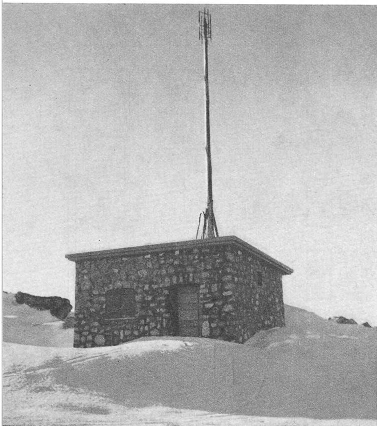
Un radiogoniomètre automatique, installé à la Dôle, indique au contrôleur des voies aériennes, la direction des avions avec lesquels il est en contact.
