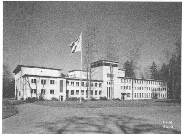
Vue des bâtiments des bureaux techniques et des souffleries subsoniques.
