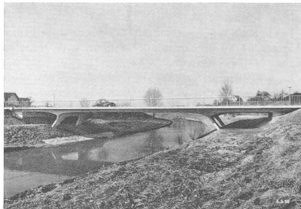
Fig. 1. — Pont sur la Glatt à Opfikon.
