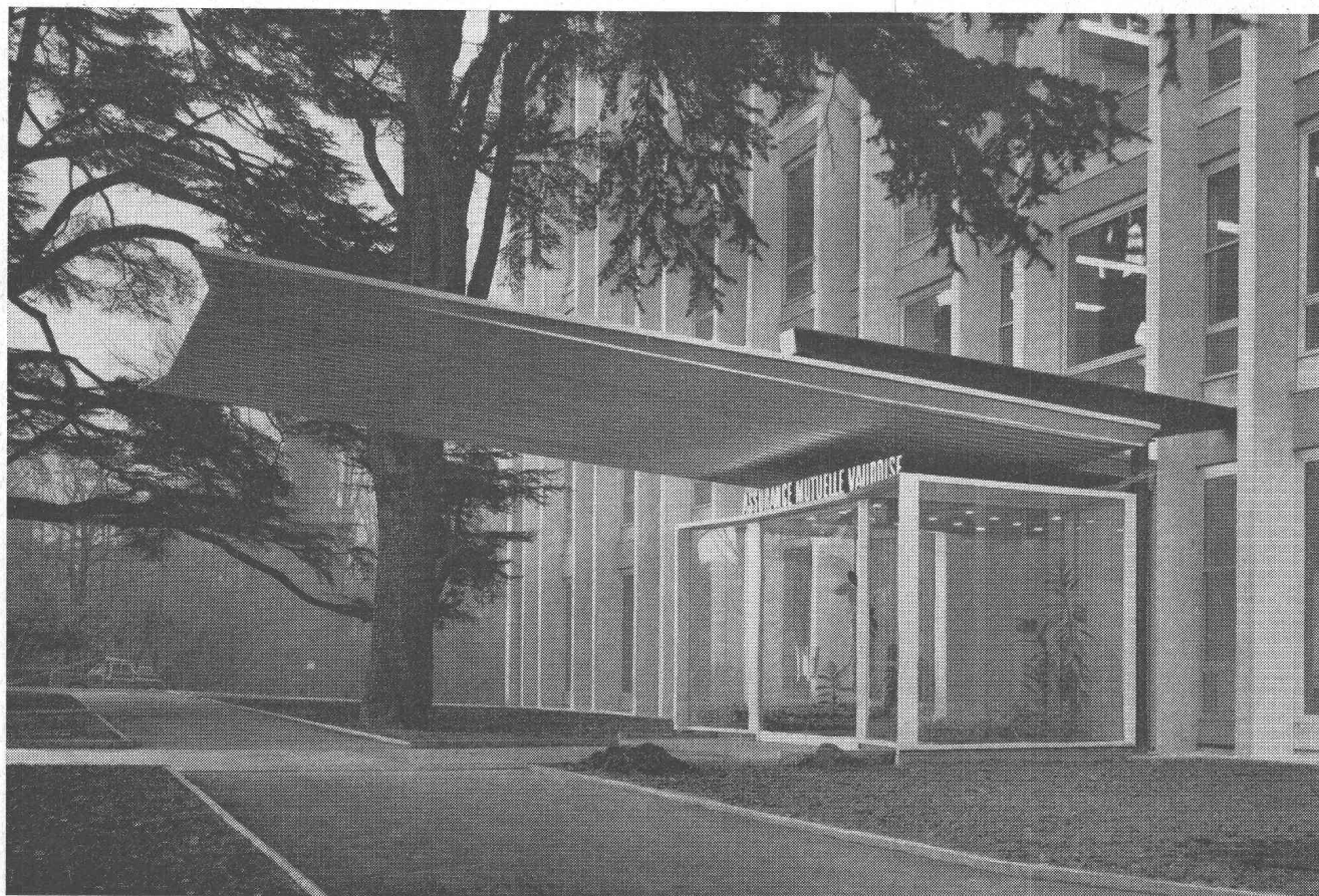
Marquise de la Mutuelle vaudoise. — Architecte : M. J. Tschumi ; Constructeur : Zwahlen & Mayr S. A.
