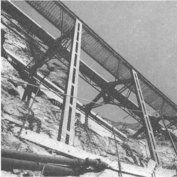
Fig. 8. — Pont 3 de Mauvoisin vu de l'aval.
