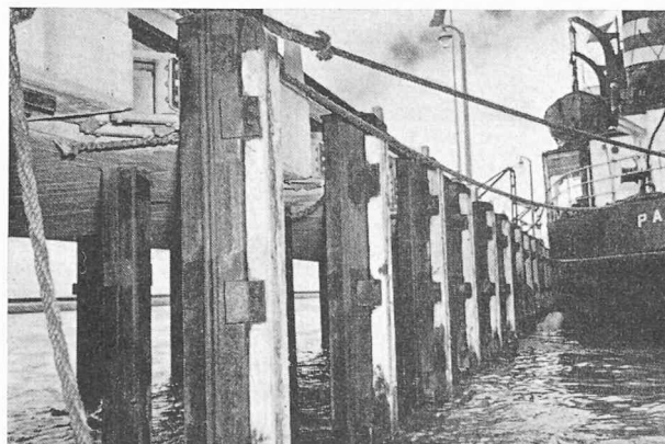
Fig. 14. — Jetée anglaise, équipée de Fender Neidhart.
