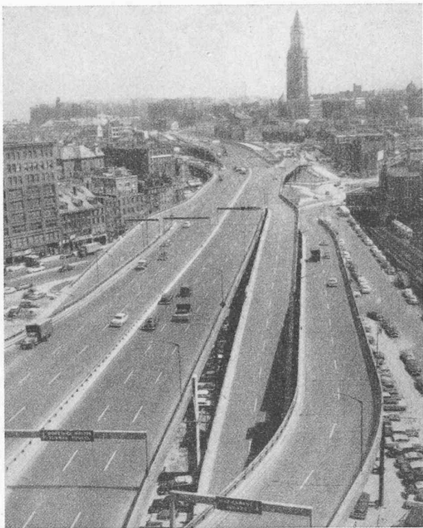
Fig. 14. — Route express surélevée, à Boston (Mass.). Rampes d'accès avec liaisons directes au réseau urbain.
