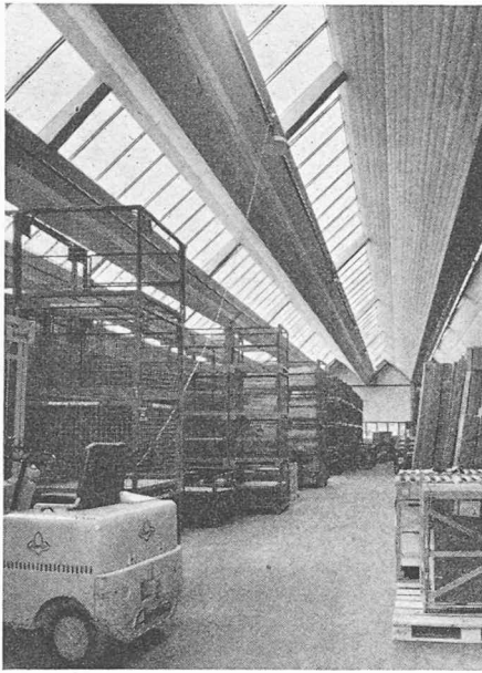
Fig. 6. — Voile mince plissée précontrainte de 36 m de portée (Siemens-Zurich).
