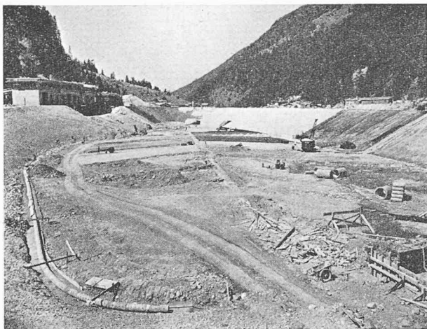
Fig. 14. — Vue d'amont vers l'aval. Etat des travaux été 1957. A gauche, drain de pied.
