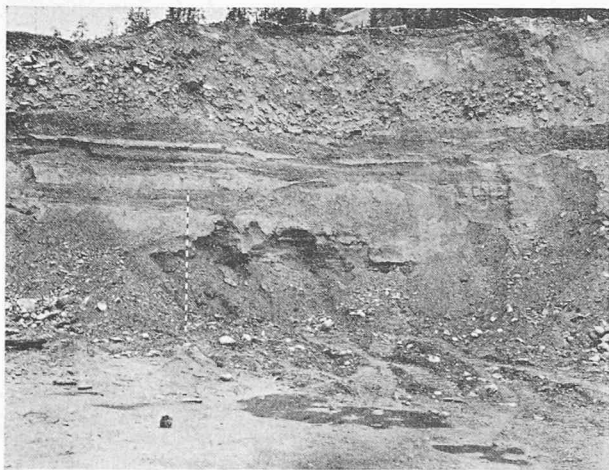
Fig. 8. — Excavation sur rive gauche.
