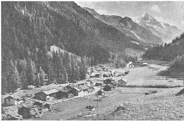
Fig. 2. — Motec avant les travaux.
