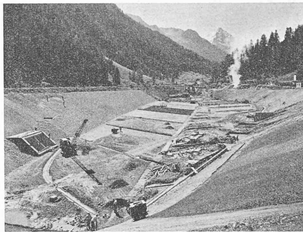
Fig. 15. — Vue générale du bassin, état des travaux, été 1957.
