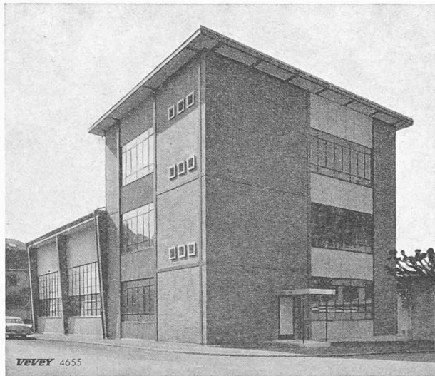
Fig. 2. — Vue extérieure du nouveau laboratoire de mécanique des fluides des Ateliers de Constructions Mécaniques de Vevey S.A.
