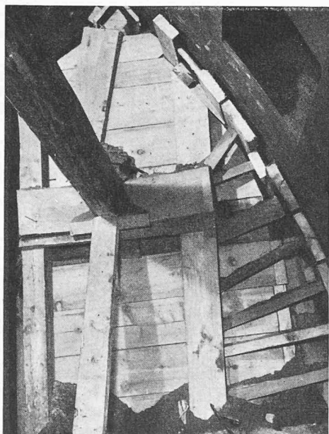
Fig. V/7. — Etayage du front d'attaque, sous le faite.
