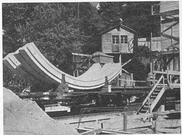
Fig. V/6. — Transport des voussoirs, par anneau complet sur wagon de chemin de fer.
