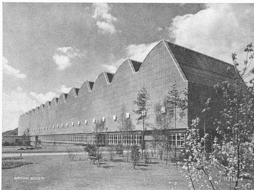
Fig. 1. — La nouvelle usine Brown Boveri à Birr, vue de l'est.
