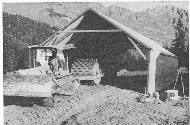
Photo n° 3. — Vue de l'aire d'essai.
