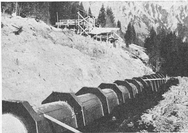
Photo n° 2. — Galerie de l'évacuateur de crues.
