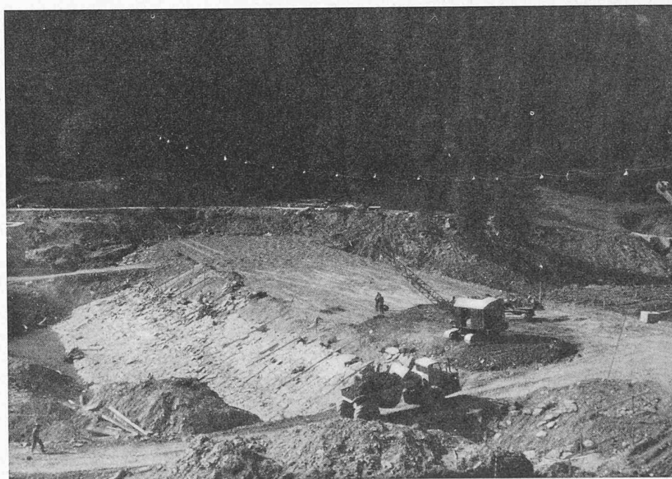
Photo n° 8. — Vue de la digue et du perré en construction.
