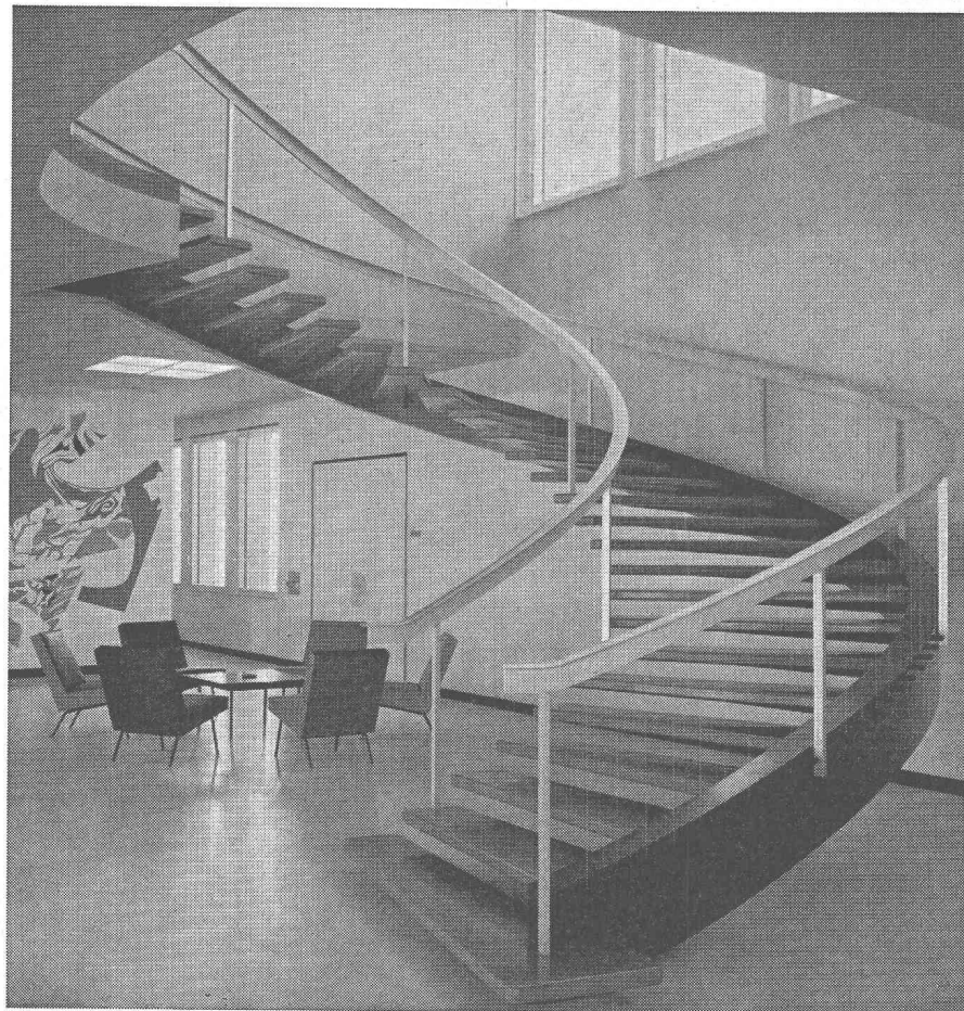
Escalier métallique avec rampe en métal léger.
