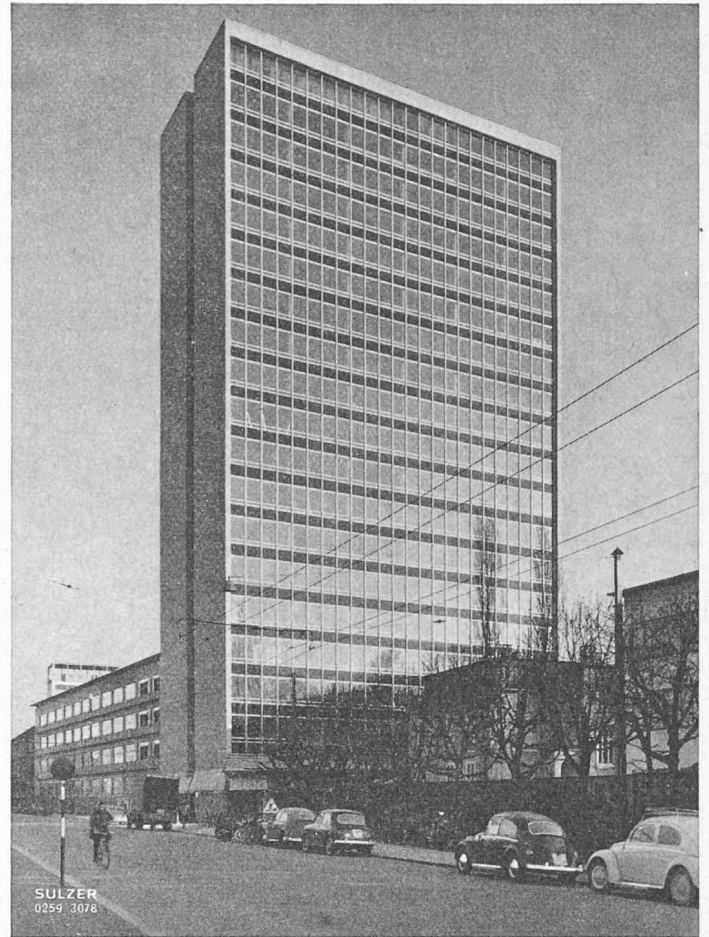
Fig. 11. — Bâtiment des bureaux dans une entreprise de l'industrie chimique, à Bâle.
