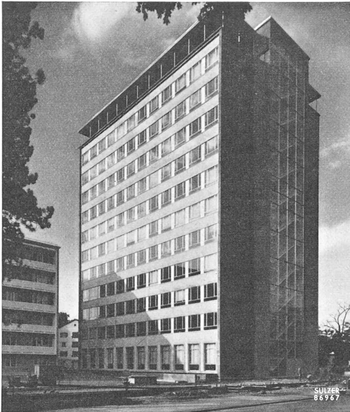
Fig. 4. — Bâtiment administratif de grande hauteur, à Bâle, avec installation de climatisation classique et réglage par zones de cinq étages chacune.
