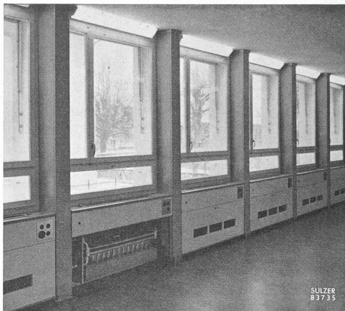
Fig. 7. — Convecteurs-climatiseurs masqués par les boiseries dans un bureau d'administration.
