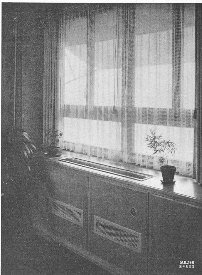
Fig. 8. — Convecteur-climatiseur masqué par les boiseries, dans un bureau de direction.
