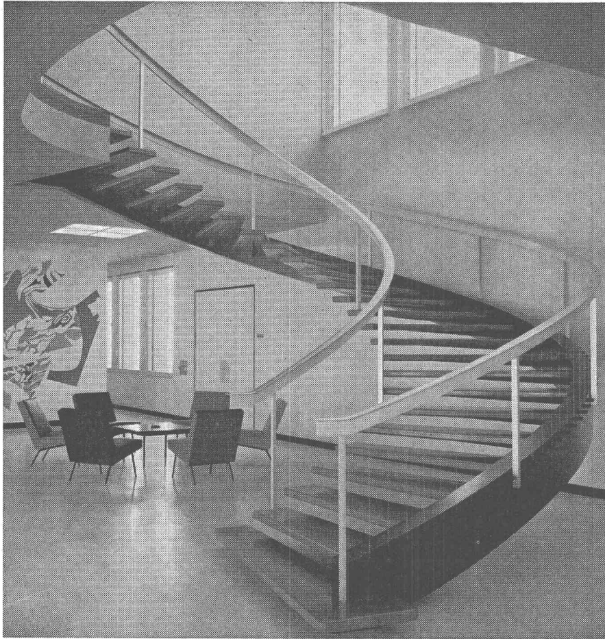
Escalier métallique avec rampe en métal léger.
