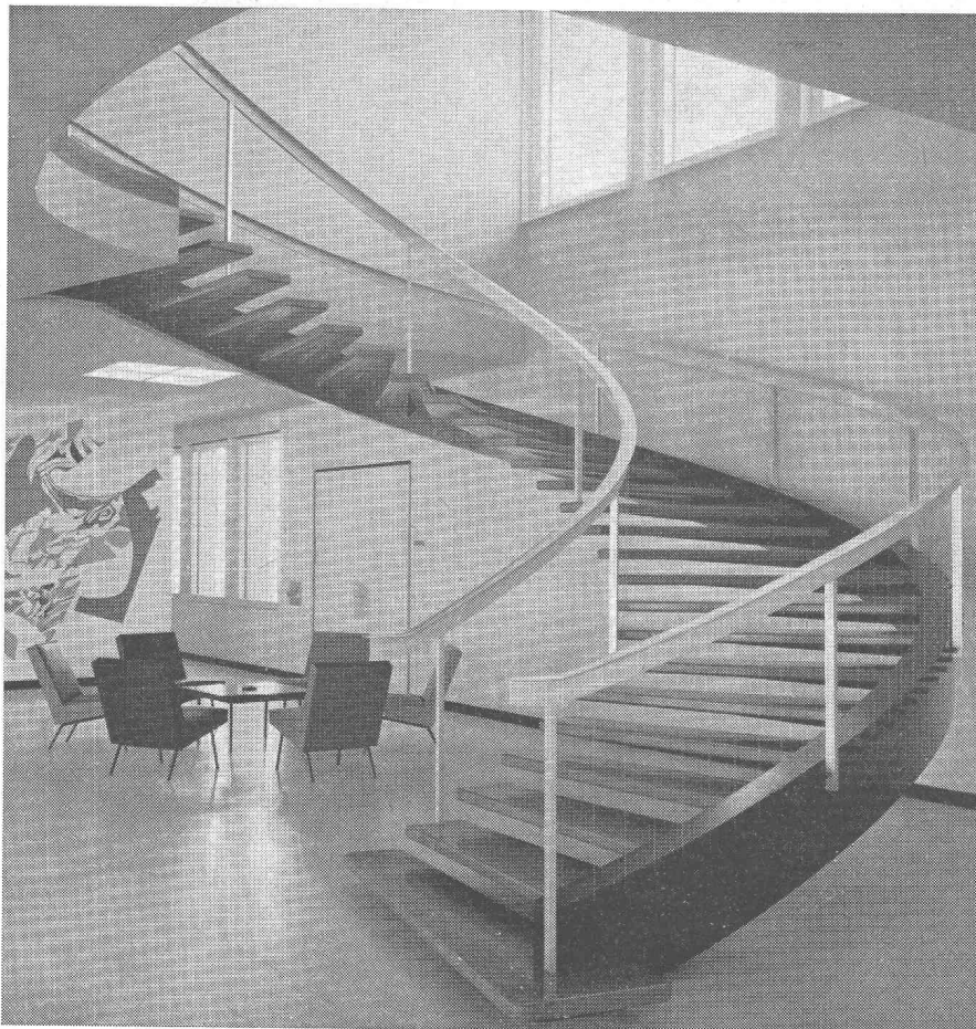
Escalier métallique avec rampe en métal léger.
