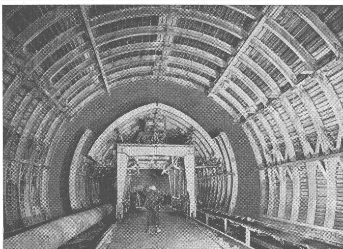
Coffrage télescopique pour le tunnel routier du Grand St-Bernard
