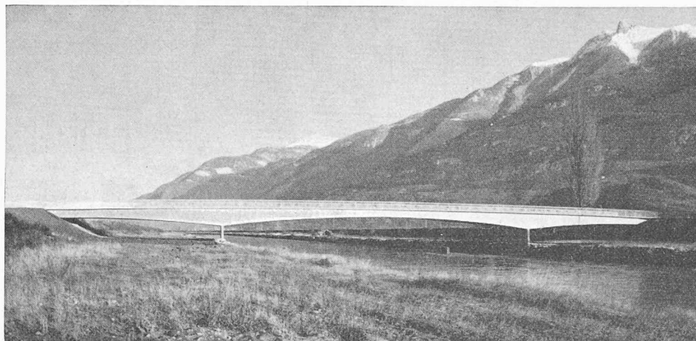
Fig. 6. — Vue du pont terminé.
