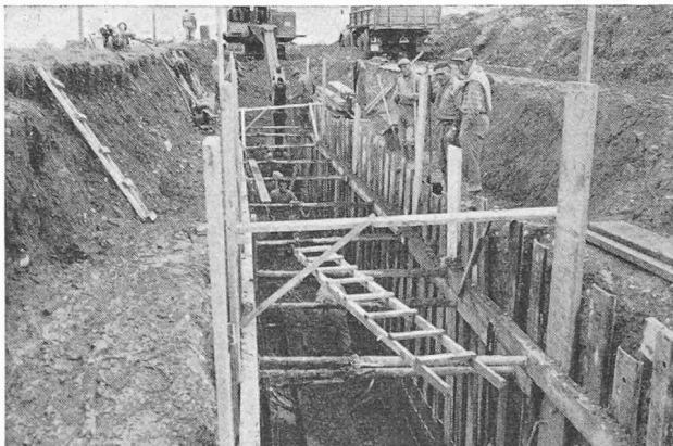
Fig. 5. — Terrassement en fouille ouverte.
