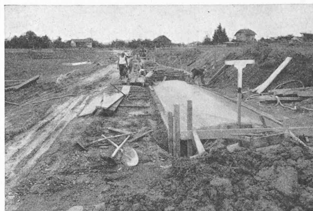
Fig. 8. — Etalement du chantier.
