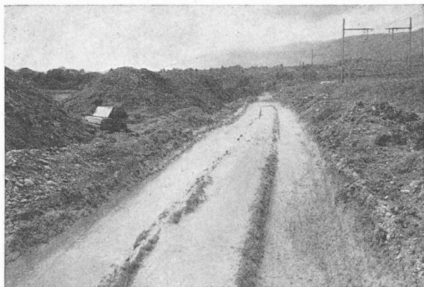
Fig. 9. — Voie d'accès transformée en fondrière.
