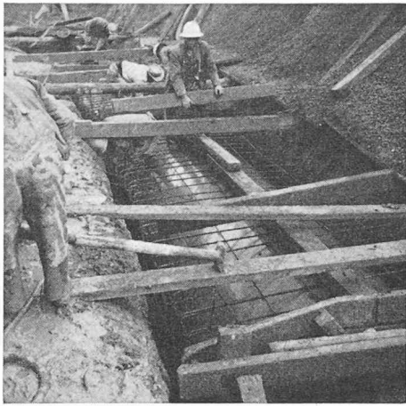
Fig. 3. — Calage du « ductube ».
