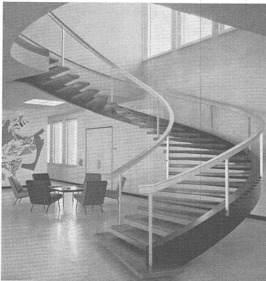
Escalier métallique avec rampe en métal léger.
