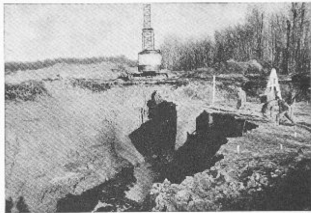
Fig. 10. — Canal du Saint-Laurent. Tranchée d'essai.
