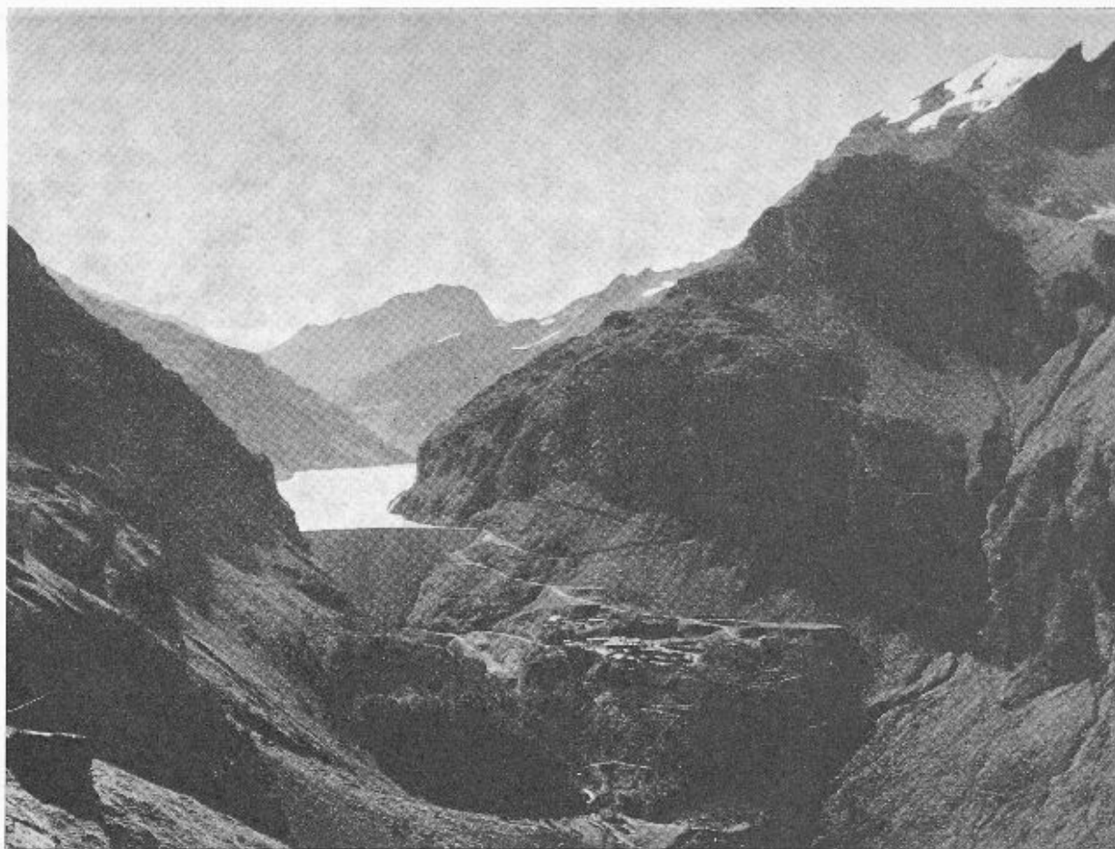
Fig. 9. — Le barrage et le lac de Mauvoisin, vus d'aval.
