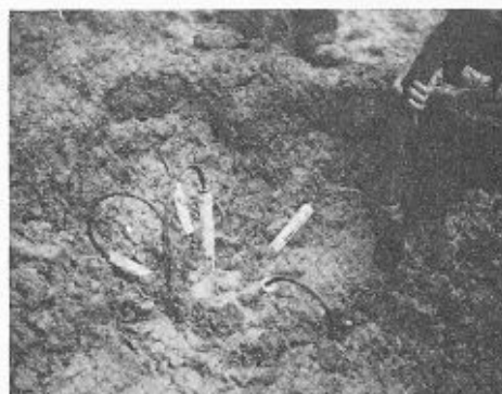
Fig. 2. — Mise en place des sondes de mesure dans une tranchée aménagée dans le béton frais.
