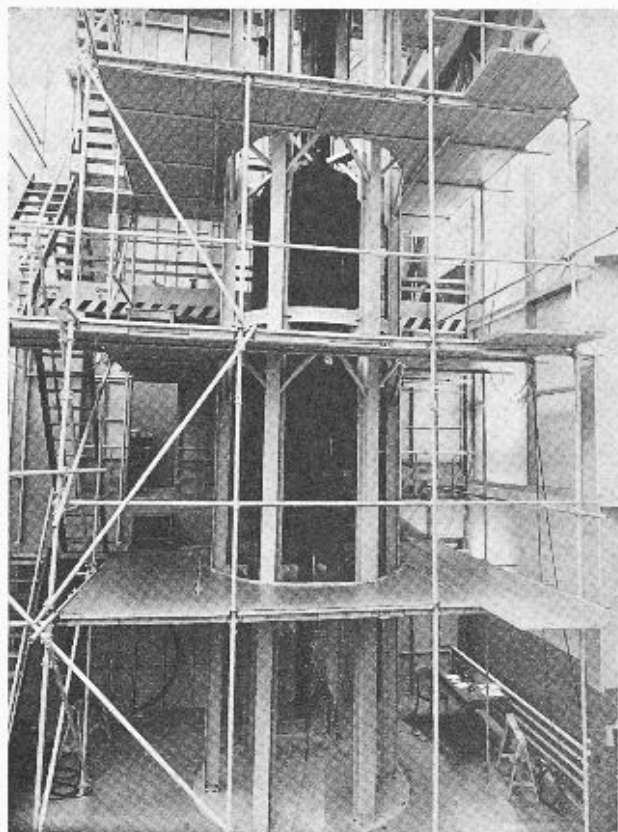
Vue d'ensemble de la partie inférieure de la machine à défourner.
