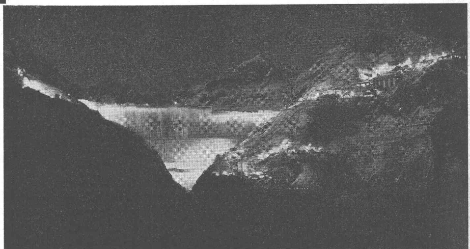
Installation d'éclairage du barrage de la Grande-Dixence (Valais), dotée de 50 projecteurs INFRANOR, Type P 1000 de 3000 W chacun
