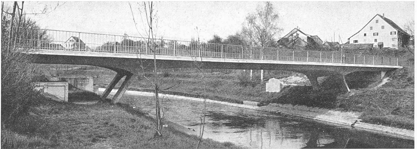
Fig. 23. — Vue du pont d'Opfikon avant les essais.
