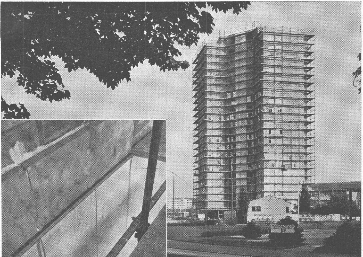
Immeuble-tour à Zurich-Schwamendingen. (Arch. MM. Fischer & Haenni à Zurich) Isolation thermique des murs extérieurs par panneaux bâtiment VETROFLEX PB.
