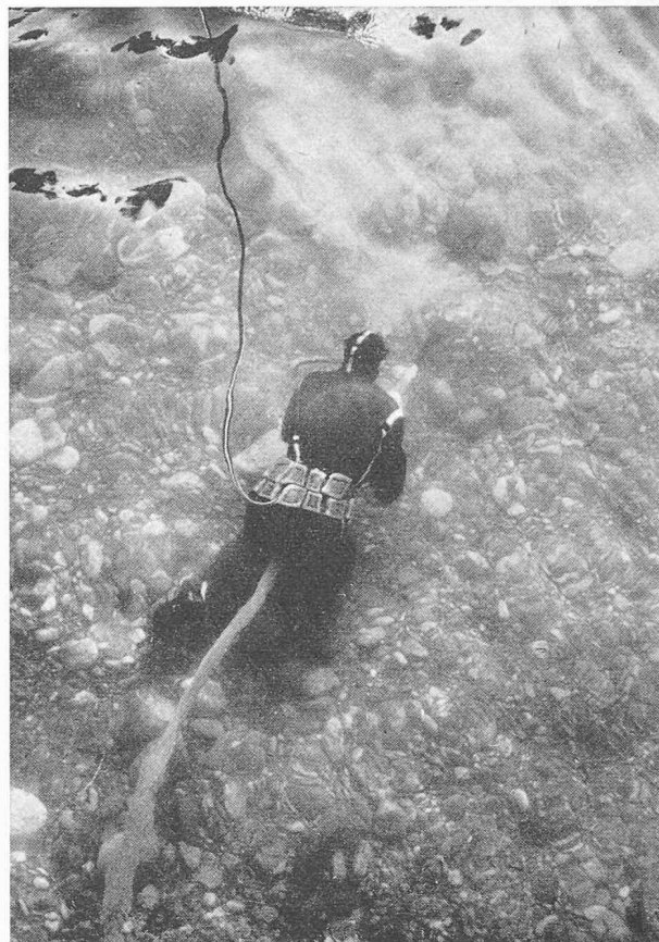
Fig. 4. — Réglage de matériaux par plongeur au moyen de la lance d'abattage.
