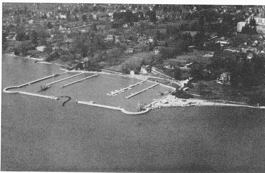
Fig. 4. — Le port et la plage de Versoix pendant la construction.
