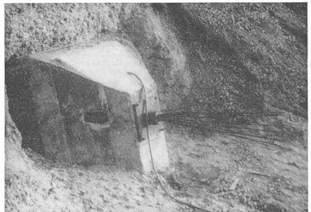
Fig. 4. — Bloc d'appui d'un tirant.
