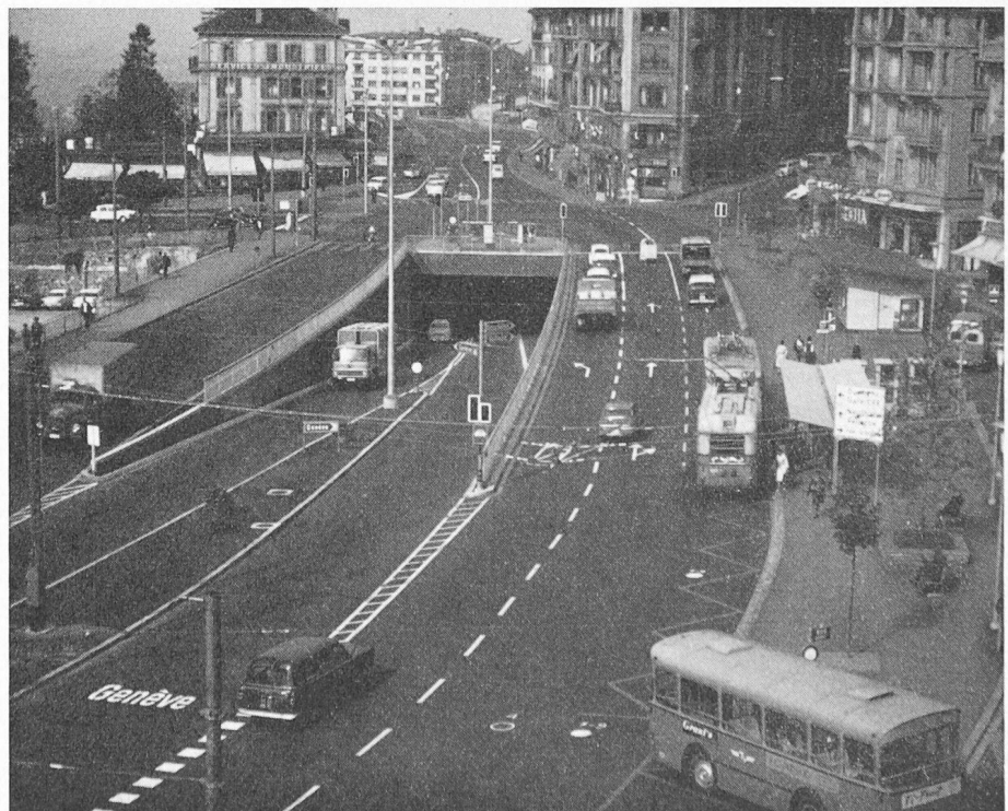
Fig. 3. — Trémie à la place Chauderon.
